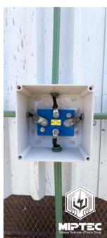
Acoplador instalado con trayectorias de referencia.
