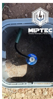
Electrodo magnetoactivo dentro de su registro.
