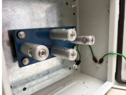
Bornes conectores del acoplador.
